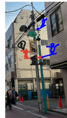
パネルの設置
