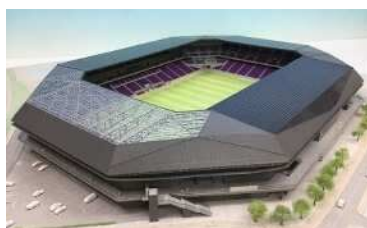
太陽光発電・蓄電池システム 出典：サンガスタジアムHP
