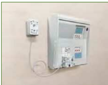
時間設定タイプ (分電盤型)
