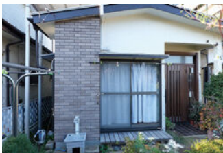
フレーム完成
