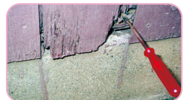
土台の腐朽度合いを調査
