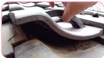
屋根瓦の葺き土の有無を調査
