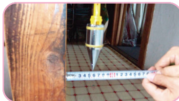
下げ振りで柱の傾きを調査
