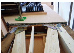
通し柱補強（室外より）
