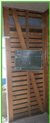
①既存壁の撤去
