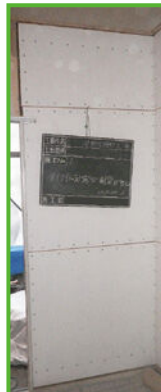
③パネルの施工
