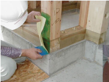
柱脚補強 (30cmシート1枚貼り)
