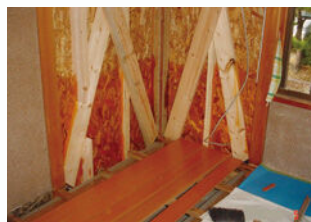
押入れ内補強
