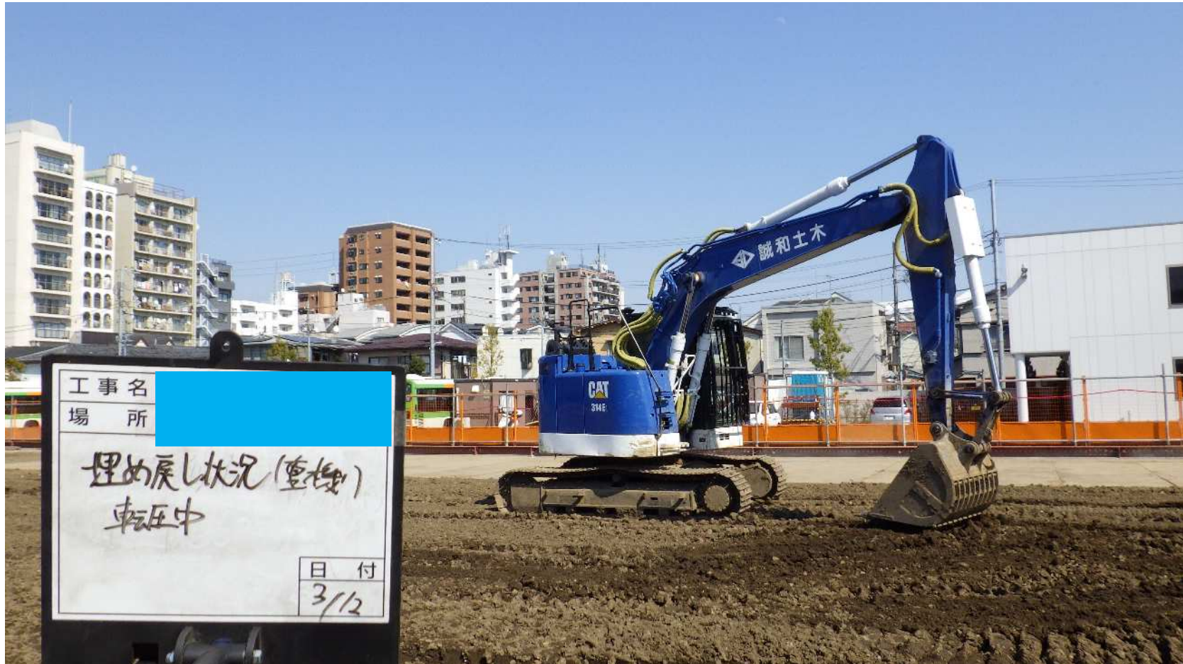
他現場の参考例（埋戻し・整地状況）
