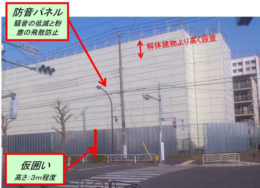
仮囲い/枠組足場+防音パネル
