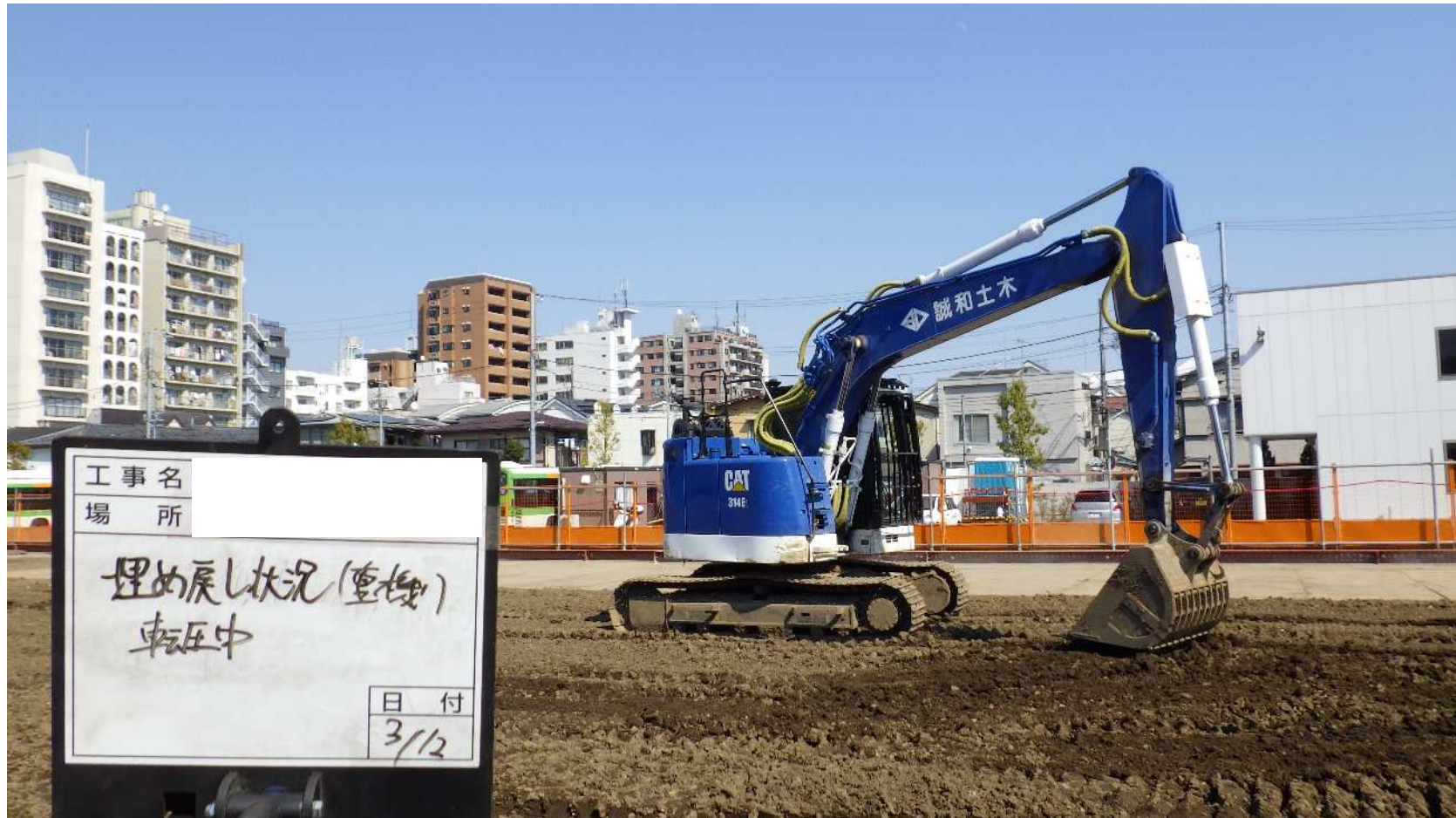
他現場の参考例（埋戻し・整地状況）
