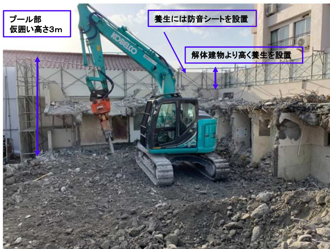
仮囲い/枠組足場+防音シート
