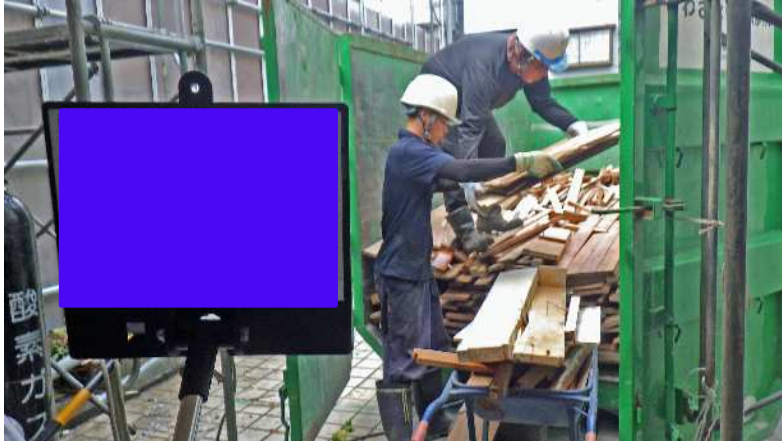
4トンコンテナ車にて発生材(木くず)の搬出
