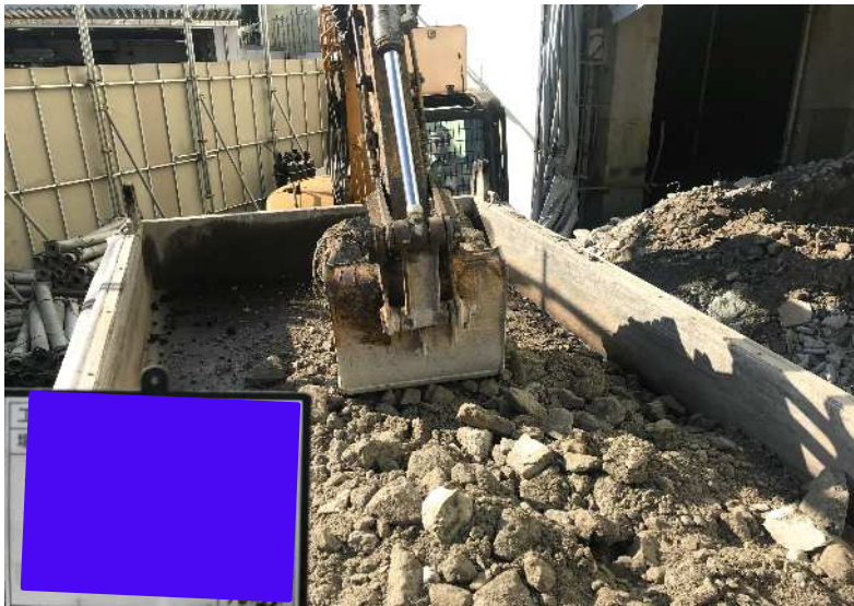
10トンドンプカーにて発生材(コンガラ)の搬出
