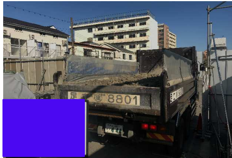
10トンドンプカーにて発生材(コンガラ)の搬出
