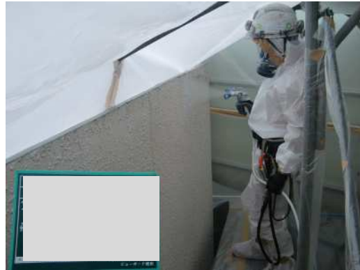
粉じん飛散抑制剤散布
