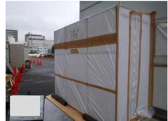
更衣室の設置
