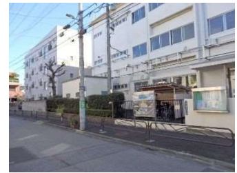
⑧北側道路から東方向
