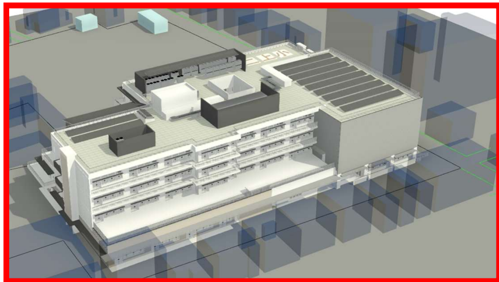
鳥瞰（南西より） 教室をセットバックし、 ご近隣との離隔を確保
