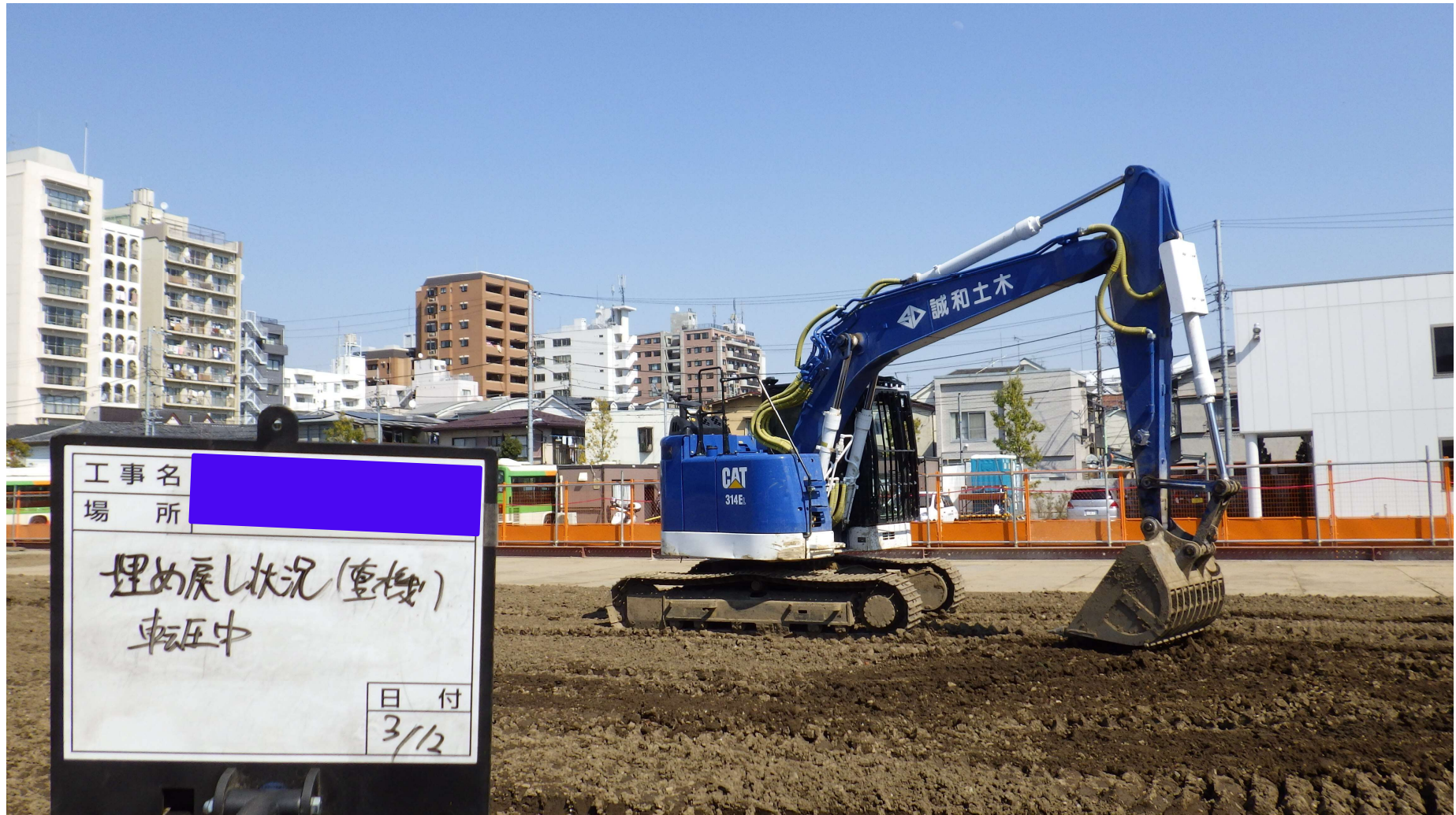
他現場の参考例 (埋戻し・整地状況)
