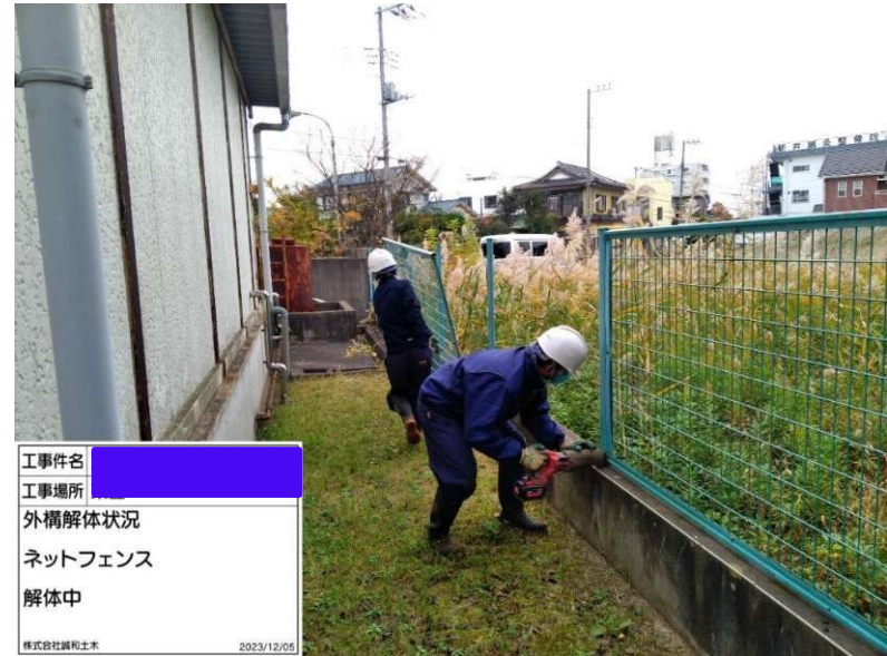
フェンス撤去
