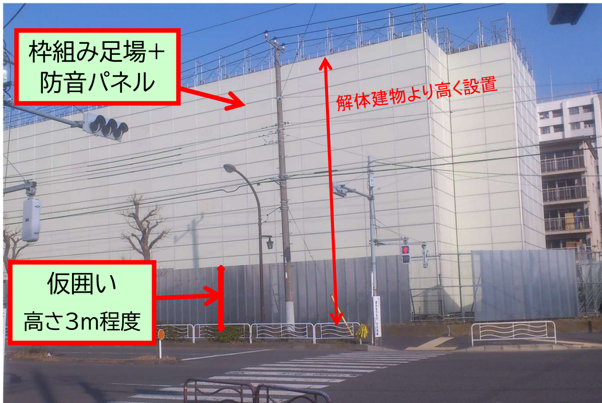
仮囲い/枠組足場+防音パネル
