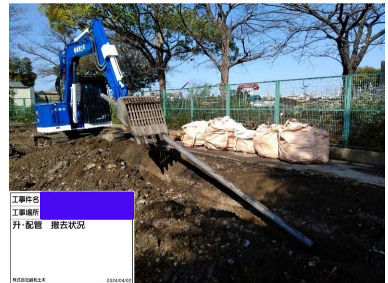
配管・桷類等撤去
