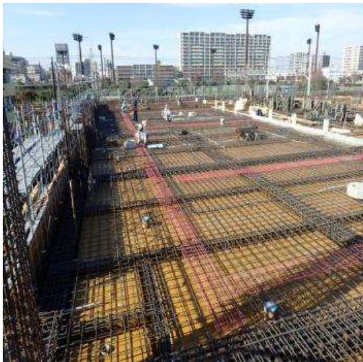
鉄筋・型枠
