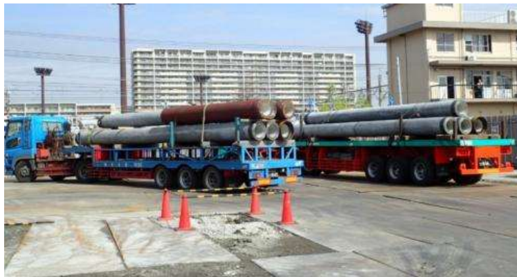
杭材を搬入するトレーラー
