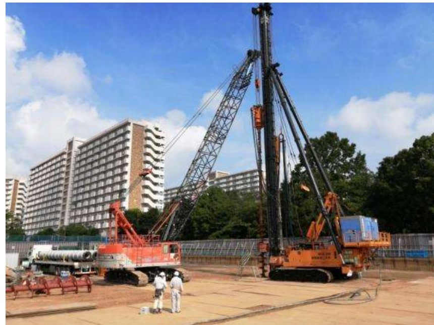
クローラクレーン
