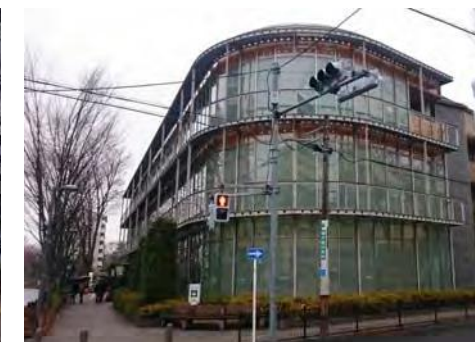
図書館と交流スペースの入った建物
