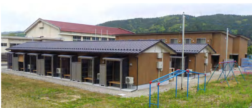
応急仮設住宅(輪島市門前町)
