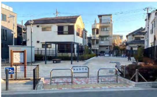
防災機能を備えた広場↑ 葛飾区・みなみ広場(四つ木地区)
