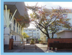
▼老朽化した建物
