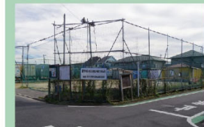
■気になるブロック塀と路地
