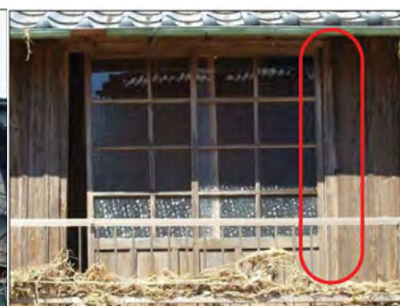
建具：損傷程度25%
