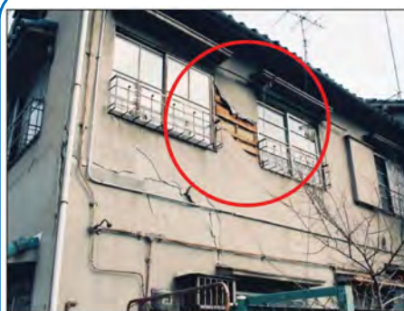
壁：損傷程度50%
