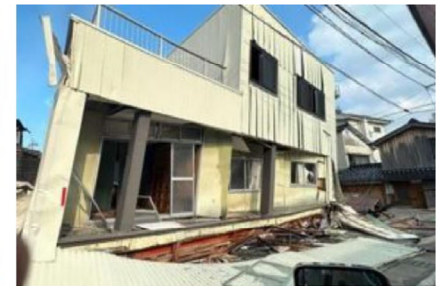
崩壊・傾斜した鉄骨造
