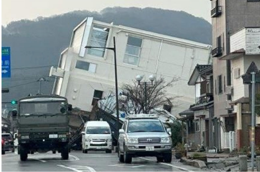
倒壊したRC造 ↓
