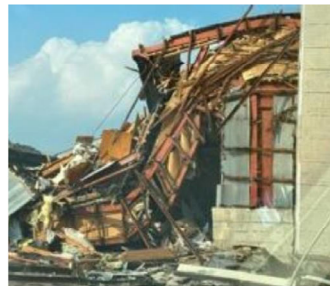
崩壊・傾斜した鉄骨造
