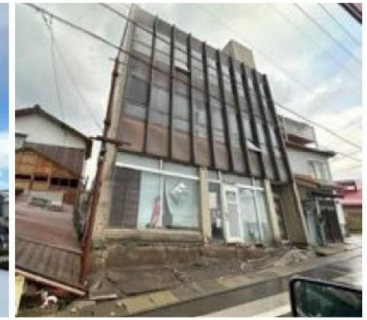
傾斜が残るRC造
