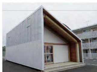
仮設集会所 (宮城県女川町)
