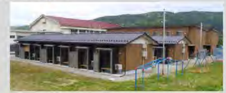
応急仮設住宅(輪島市門前町)
