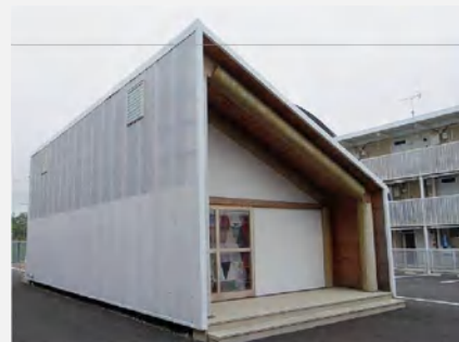
仮設集会所 (宮城県女川町)
