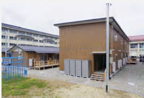
仮設住宅 (石川県輪島市門前町)
