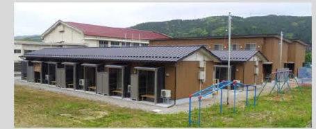
応急仮設住宅(輪島市門前町)
