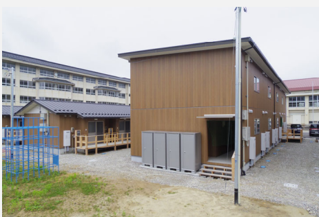
仮設住宅 (石川県輪島市門前町)
