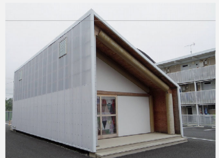
仮設集会所 (宮城県女川町)
