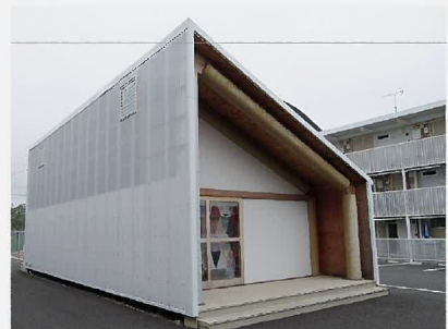
仮設集会所 (宮城県女川町)
