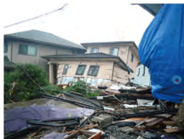
ゆれによる被害の様子 (熊本県益城町)
