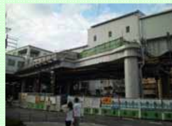
エレベーターの設置が予定されている場所
