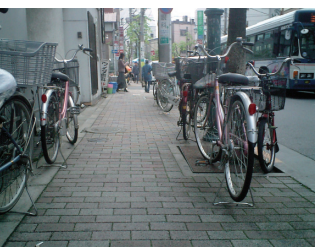
商品の道路へのはみ出しや放置自転車等の点検
