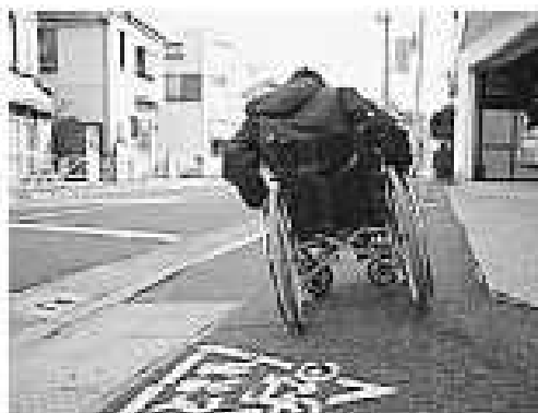
歩道勾配改善事業実施前
