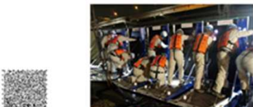
止水板を組み立てている様子
