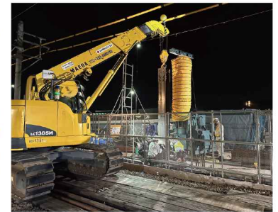
土留杭設置の様子
