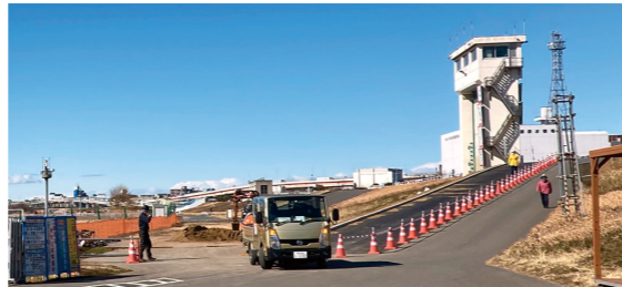
工事車両搬入のために拡幅された坂路
