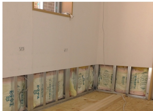
断熱材の交換
