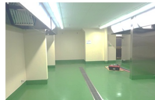
5) 店舗での塗床の例
