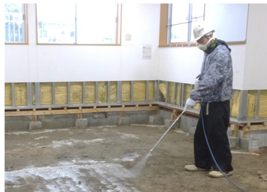
床下清掃・消毒作業
