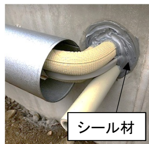
配管貫通部処理の例
