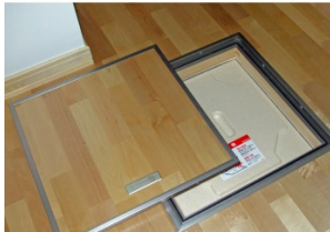
1) 床下点検口の設置
