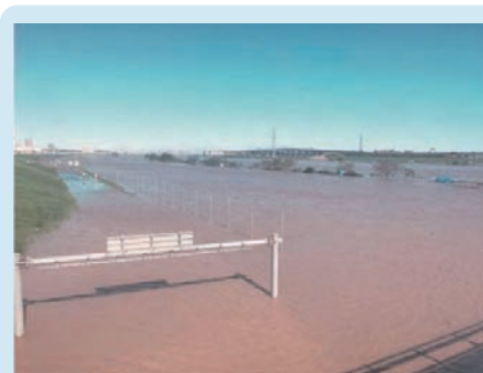
令和元(2019)年東日本台風にて 増水した荒川
