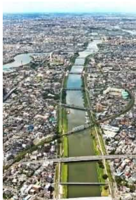
多くの橋が架かる新中川
