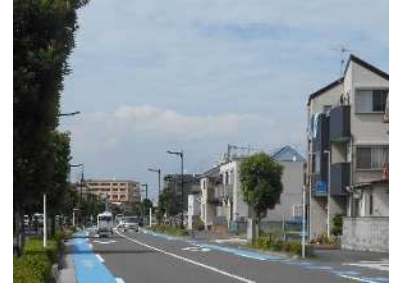
整備された都市計画道路と 広幅員道路の利点を生かし きれていない沿道
