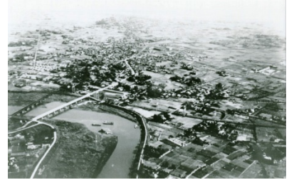
【上空から見た高砂橋(昭和初期)】
