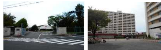
森永乳業東京工場
