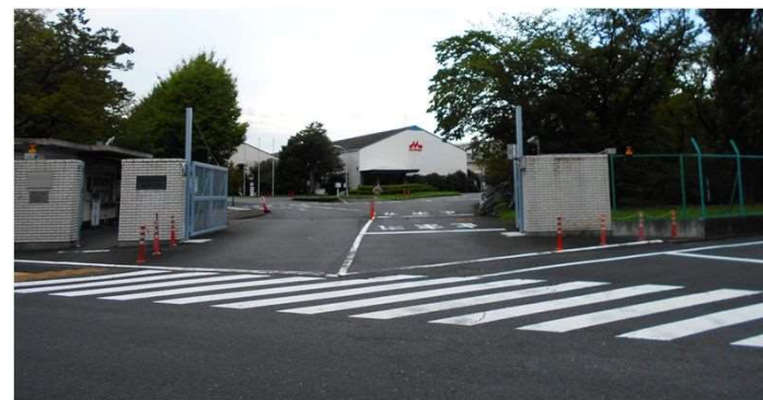
森永乳業東京工場
