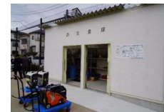
防災資器材倉庫
