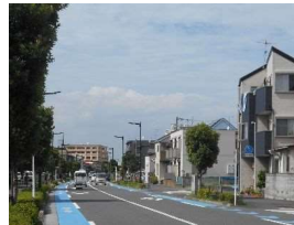
整備された都市計画道路と 広幅員道路の利点を生かして きていない沿道
