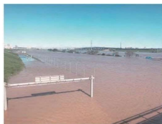
令和元年東日本台風にて 増水した荒川
