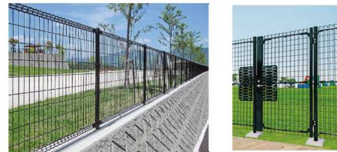
フェンス（高さ1.8m）
