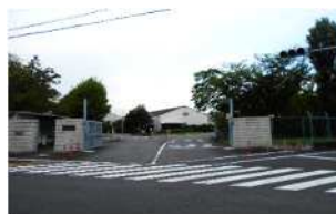
森永乳業東京工場
