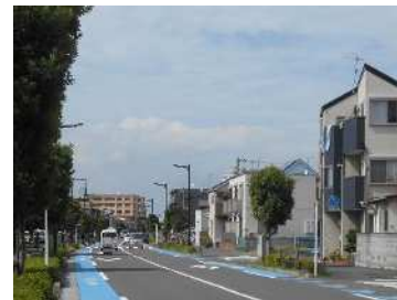
整備された都市計画道路と進まない沿道まちづくり
