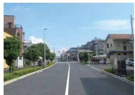
幹線道路の整備による良好な街並み
