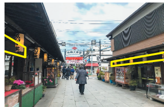
開放的な店構えを実現する太い差脚(黄色の囲み部分)が、屋根や庇と共に、参道の方向性を強調する効果を生み出している
