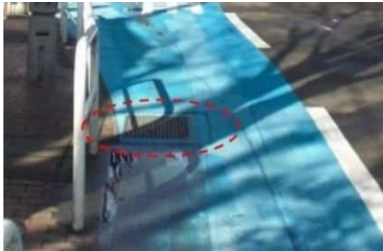
図 自転車が走行しにくい道路の事例（街渠） 出典：自転車走行空間の設計（警察庁）
