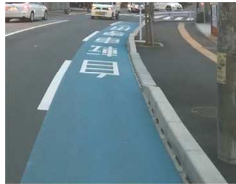
図 自転車の走行性に配慮した排水構造の例 出典：第5回自転車の活用推進に向けた有識者会議（国土交通省）
