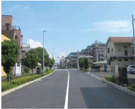
補助第276号線（隅田橋）
