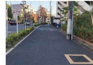
透水性舗装の整備
