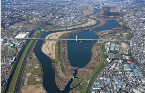
荒川洪水調節池（埼玉県戸田市、さいたま市） 洪水調節量は、東京ドーム約30杯分。 江戸川の上流部にも、同様の調節池があります。
