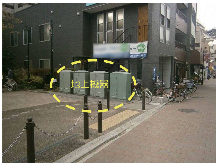
図 2.7 道路区域外活用方式の整備事例（板橋三丁目緑宿広場活用）
