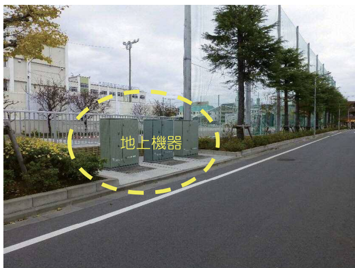
図 2.8 道路区域外活用方式の整備事例（江戸川区立瑞江第2中学校用地活用）
