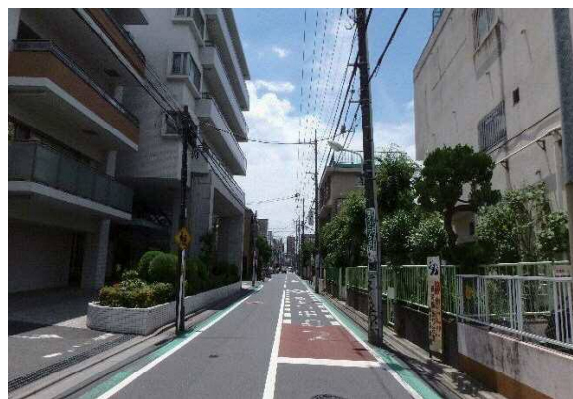
図 3.4 歩道がない道路
