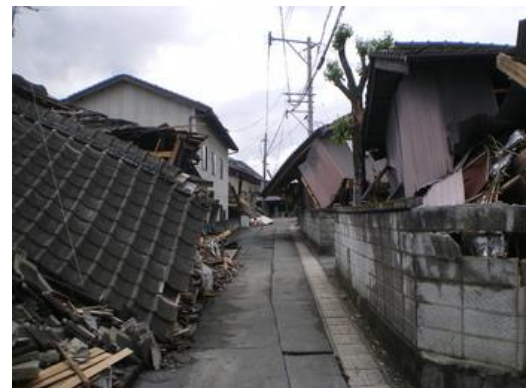
熊本地震で倒壊した建物
