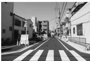
整備工事完了後
