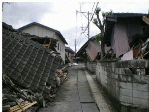
熊本地震で倒壊した建物 区派遣職員が撮影
