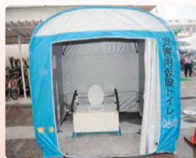
災害時にはマンホールの上にトイレを設置します。
