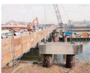
現在撤去工事中の八剣橋
