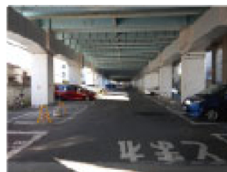
高架下の駐車場
