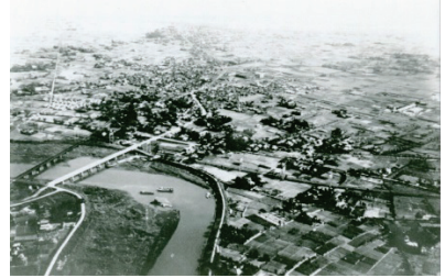
【上空から見た高砂橋(昭和初期)】
