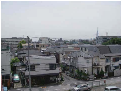
住宅が密集する市街地（西亀有・平成24年）
