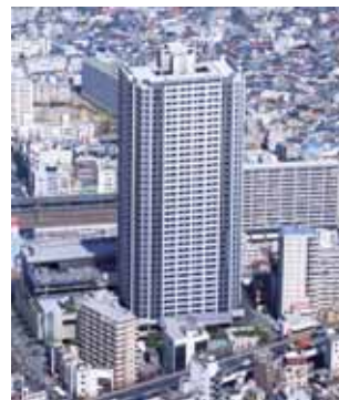
金町駅前 約400戸の住宅と商業・公益施設(葛飾区中央図書館)の再開発事業。(H21.10 完成)
