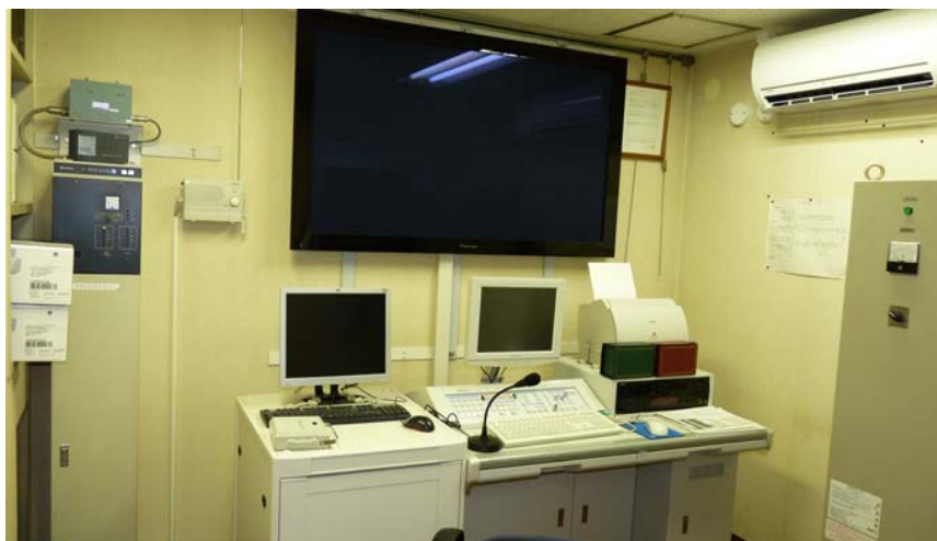
狭い防災設備室
