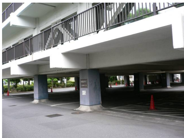
本庁舎はピロティ(高床)方式
