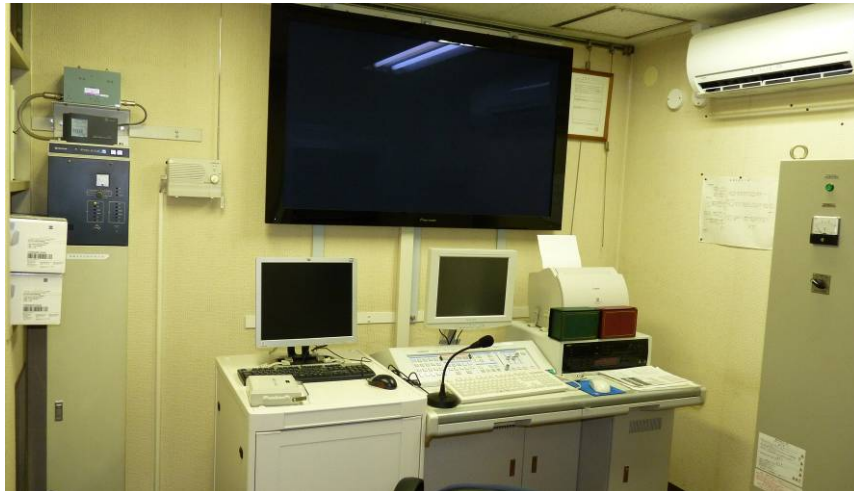
狭い防災設備室
